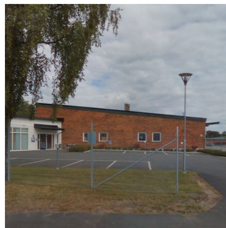
Befintlig västra byggnad, sedd från Batterivägen
