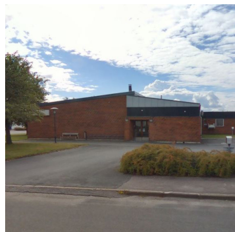
Befintlig östra byggnad, sedd från Kylarvägen
