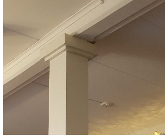
Bild 11: Invändig pelare och balk.
