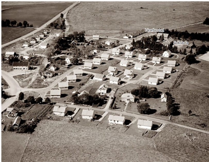
Figur 7 visar en översiktlig bild över Gudhem år 1962 där det går att utläsa den befintliga lärbostaden och folkskolebyggnaden inom planområdet.
