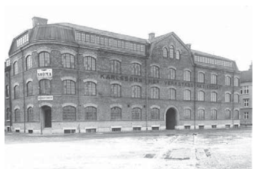
Bild 3. Karlssons Mekaniska Verkstad
