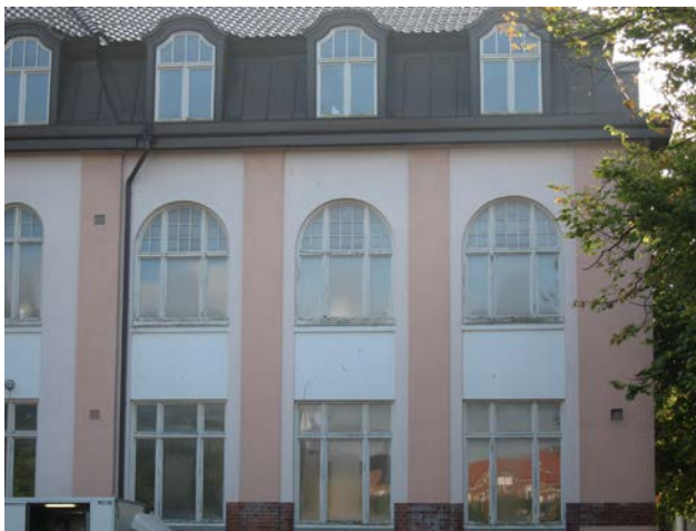
Fönstertyper på Centralskolan
