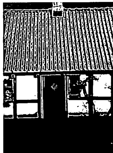
Gårdsidan av södra längan, Tunneberga Gästis
