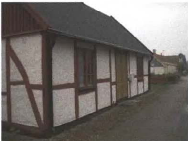
Tunneberga 2:23. Fasad utmed Jonstorpssvägen, 2007-09-14.
