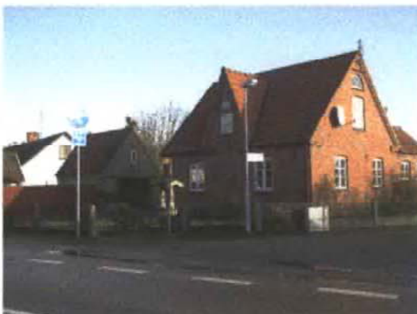
Tunneberga 2:21. Fasad utmed Jonstorpssvägen, 2007-01-19.
