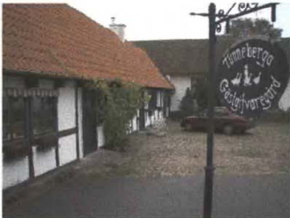
Tunneberga 2:13. Del av huvudbyggnad och norra längan, 2007-09-14.
