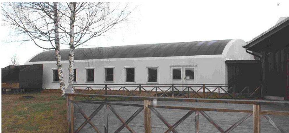
Tillfällig serveringsbyggnad som rivits
