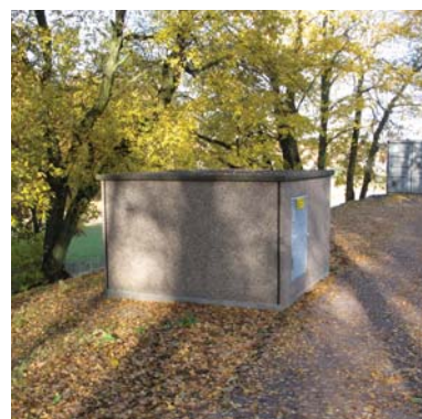
Befintlig transformatorstation norr om planområdet
