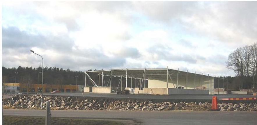
Pågående byggnation i områdets sydöstra hörn
