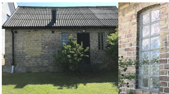
Fd brygghus, fönster med valvbåge, spöjs och glasbetong.
