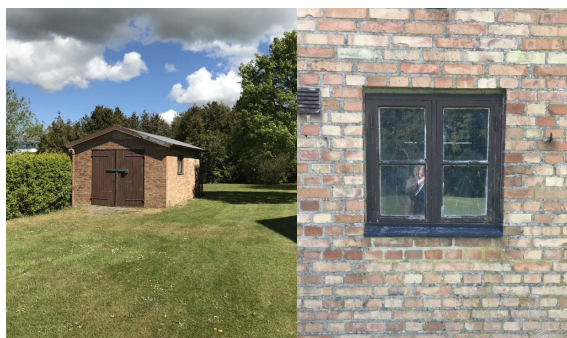
Garaget på trädgårdssidan, uppfört på 1940-talet.
