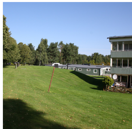
Ett av skyddsrummen norr om planområdet.
