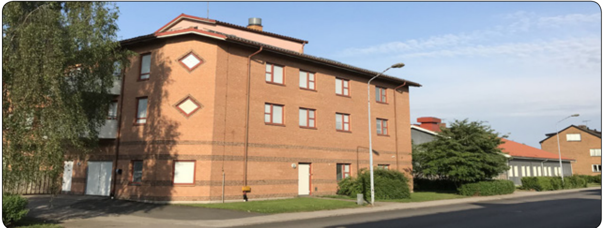
Foto taget från Malmgatan. I förgrund befintlig byggnad som ska rivas. I bakgrund byggnaden som inrymmer folktandvården
