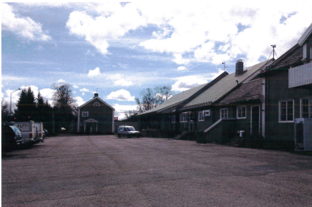
Delar av befintlig bebyggelse med stationshuset närmast i bild.
