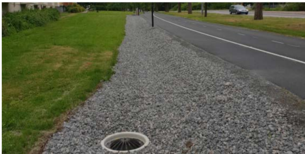
Figur 16. Exempel på makadamdike (foto: Dämningsverket).
