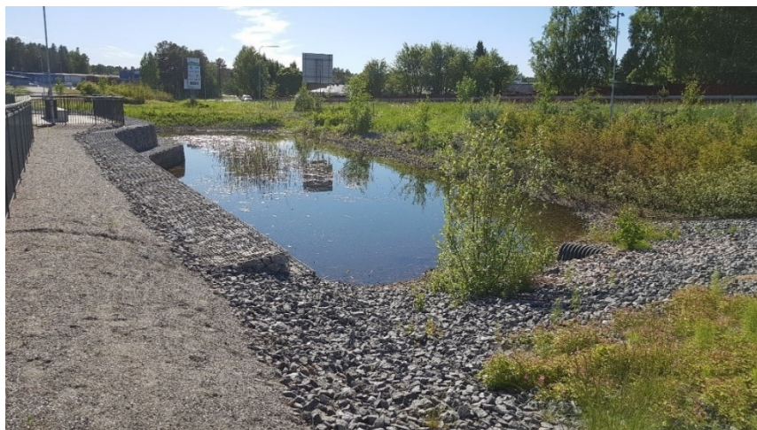
Figur 14. Exempel på dagvattendamm (foto: AFRY).
