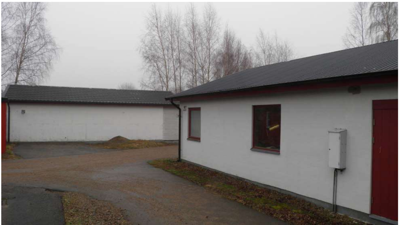
Befintligt garage och lagerbyggnad inom Sjöborg 1:24.
