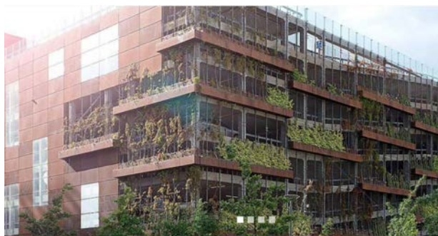
Exempel på utformning av parkeringshus (Dockan, Malmö)
