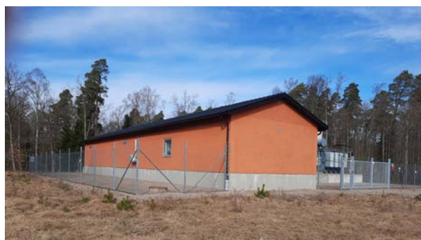
Fördelningsstation, Laholms kommun
