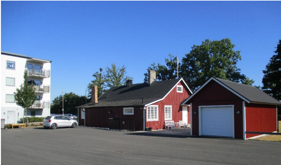
Strandstugan, vy från baksidan, parkeringsplatsen.
