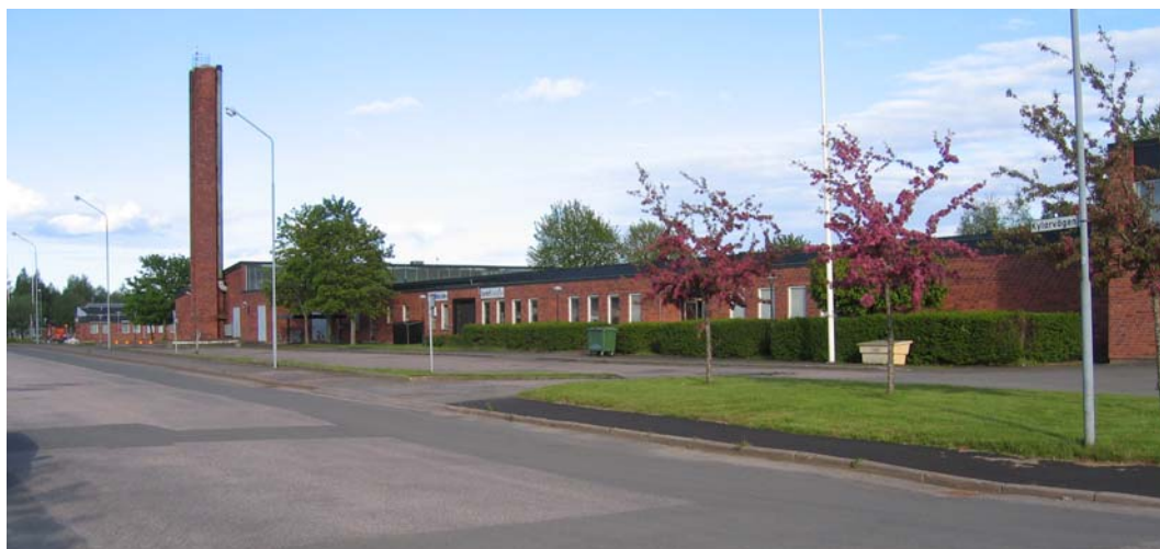
Bild 3. Kv Ventilen från Kylarvägen
