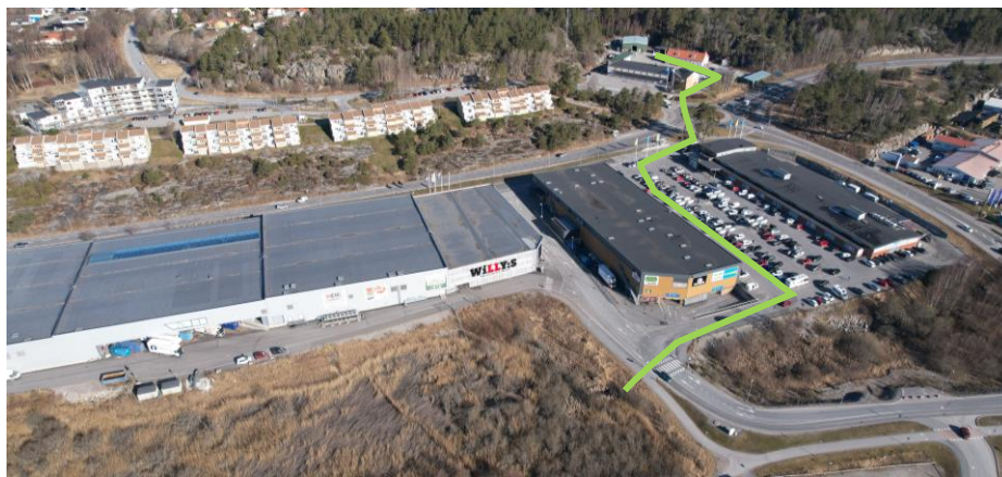
Figur 4 Dagvattenledning som leder dagvatten och vatten från naturmark från planområdet till utloppspunkten vid ett våtmarksområde innan vattnet går ut till Strömsvattnet (ledning är här illustrerad med grön linje). Drönarfoto 3 april 2022, Sweco.
