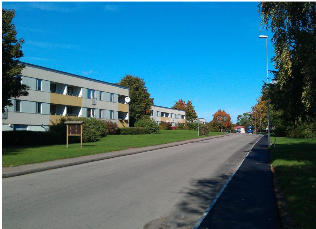
Lillängsvägen vy mot centrum.
