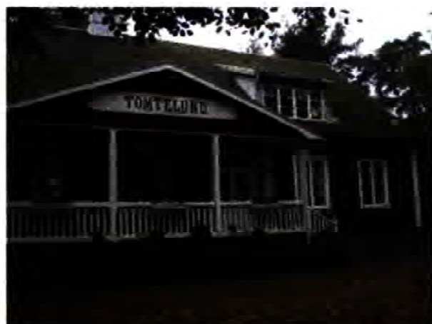
Tunneberga 1:28. Fasad mot öster, 2007-09-14.
