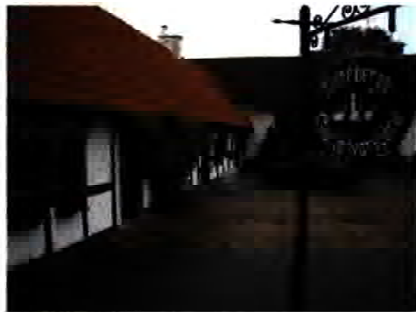
Tunneberga 2:13. Del av huvudbyggnad och norra längan, 2007-09-14.
