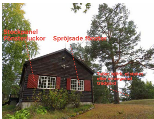
Figur 28 Exempel på bevaransvärda detaljer att bevara och/eller vidareutveckla: Stockpanel, fönsterluckor, spröjsade fönster, taller, björk, naturtomt utan arrangerad trädgård eller staket. Källa: kulturmiljöinventering, 2017
