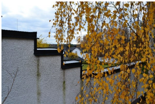
Figur 63 Del av mur vid Strömmadal. Foto: Anna Fredriksson
