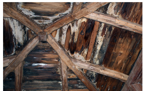
Utedassets interiöra takstomme är belagd med skyddsbestämmelse q 2 .
