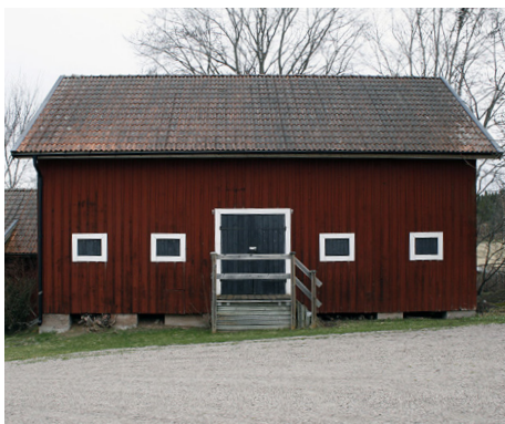
Magasinet, faluröd färgsättning med få vita detaljer. Taket belagt med lertegel.
