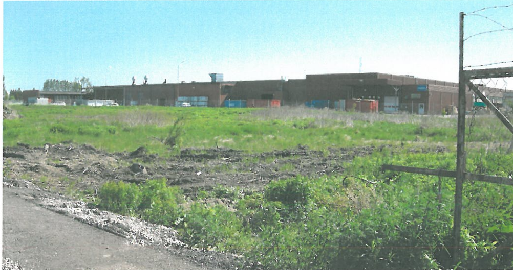
Fastigheten med utsikt mot Haldex.
