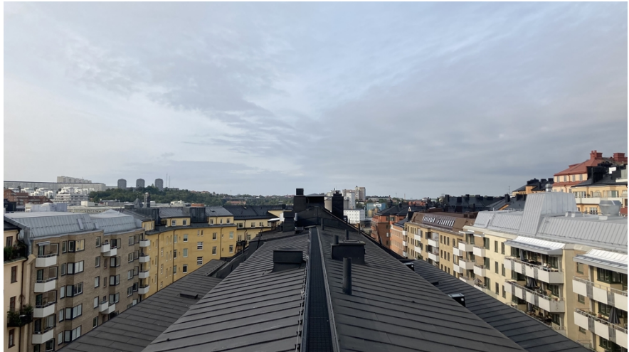
Vy på taket västerut mot Liljeholmsviken (Stadsbyggnadskontoret).
