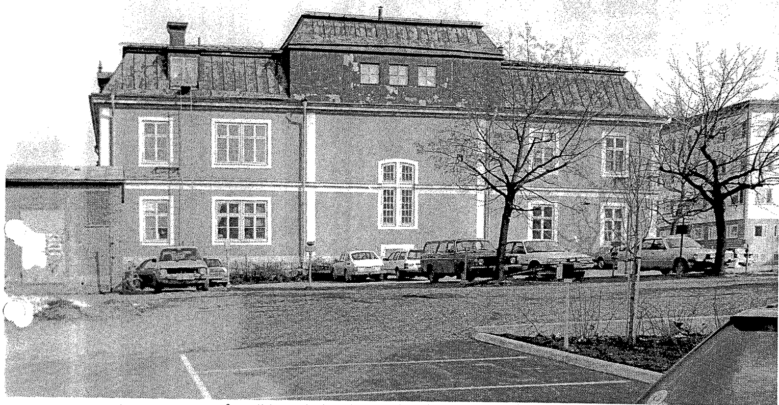
Gamla Teatern från söder, baksidan med uthus och parkering
