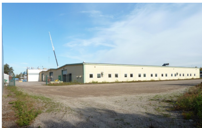
En del av planområdets grusytor och byggnader.
