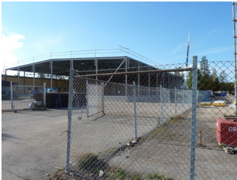
Den nya byggnaden på Lenhovda 109:2 som byggs över dagvattenledningen.
