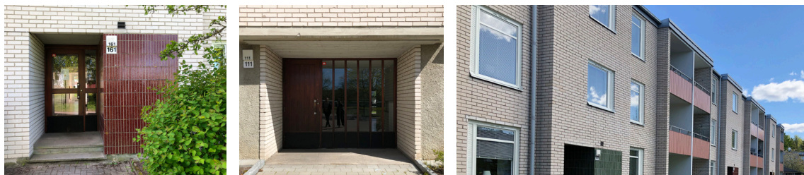
Till vänster: de befintliga lamellbusens entréer med mosaik och glas, som ger sikt genom huset Till höger: indragna och svagt utskjutande partier som på ett diskret sätt skapar en rytm och variation i fasaden.
