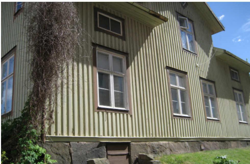
Byggnadens västra fasad med källaringång och en naturstensmur.
