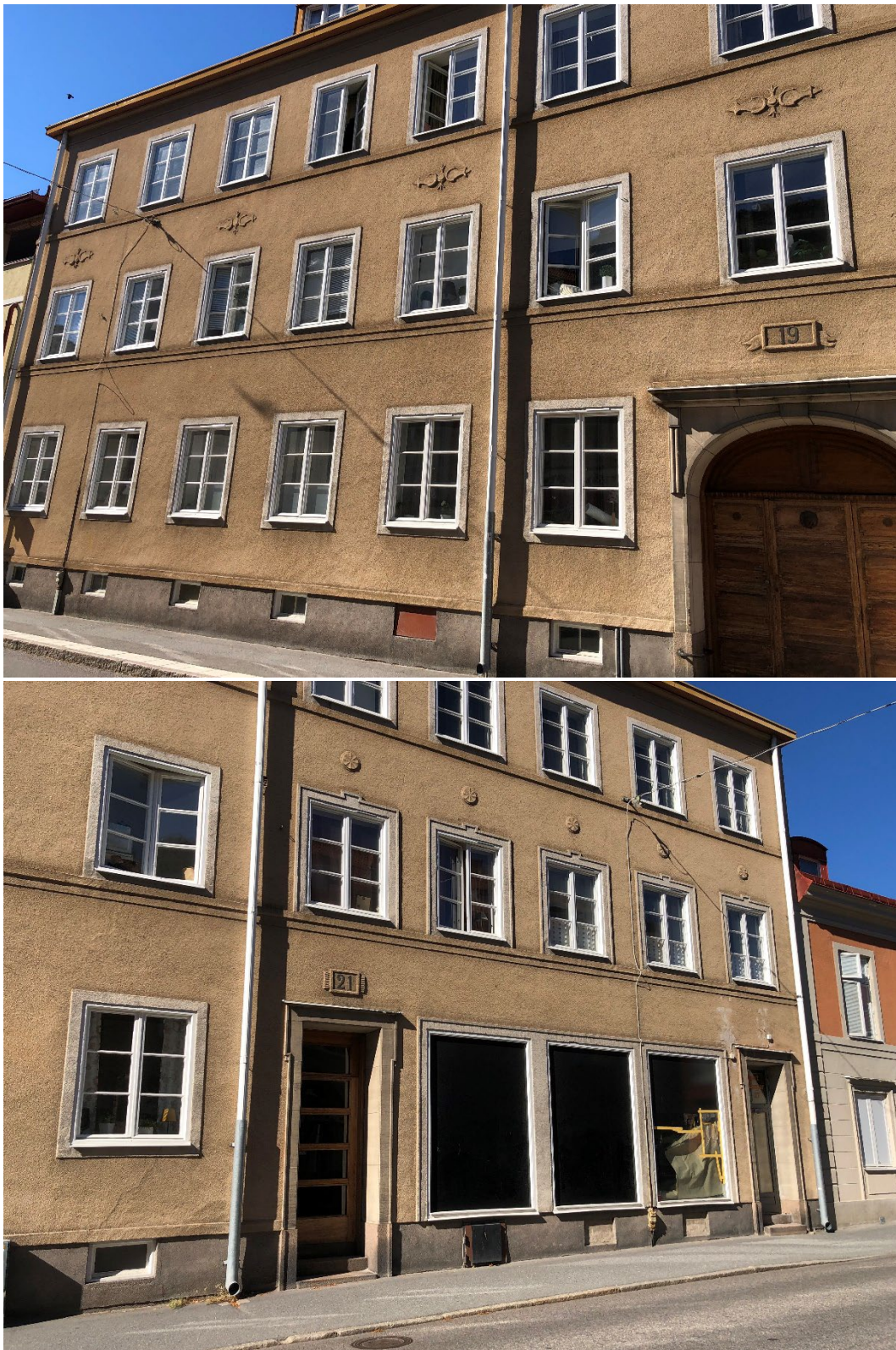
Figur 13. Hus 2 inom fastigheten Klädeshandlaren 14, Västra Kvarngatan 19-21. Här syns den putsade fasaden, listverk och delar av de tidstypiska dekorationerna.
