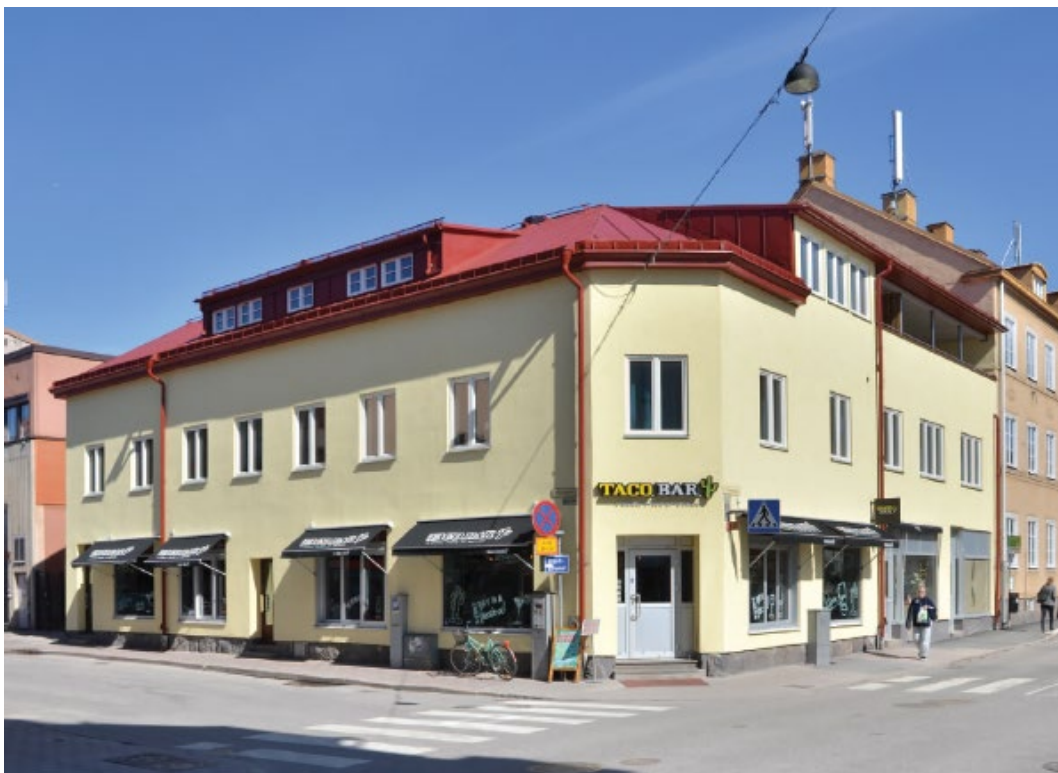
Figur 17. Hus 4, Klädeshandlaren 14, Brunnsgatan 34 och Västra Kvarngatan 14.
