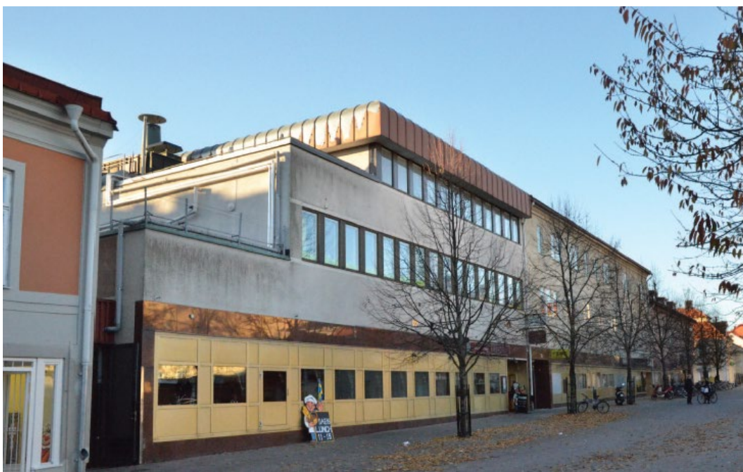
Figur 10. Fasad mot Västra Trädgårdsgatan. Här syns byggnadens ursprungliga karaktär.
