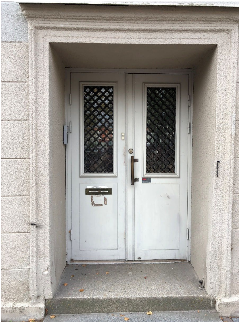
Figur 12. Bilden visar ursprunglig entréport till hus 1.
