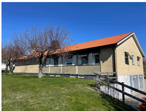
Bild 12 Bild som visar Polishuset, från insidan av kvarteret. Till vänster på fasaden de förstärkta upphöjda fönstren och till höger fönsterpartierna med träbeklädnad och puts. Längst till höger i bilden syns nedfarten till garageutrymmena under byggnaden.
