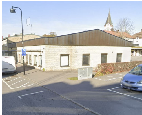
Bild 14 Bild som visar befintligt posthus som rivs för att ge plats till ny vårdbyggnad.
