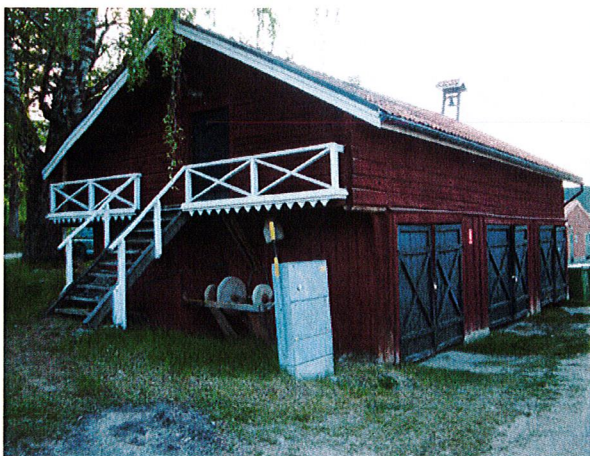
En äldre ekonomibyggnad sannolikt från tidigt 1800-tal
