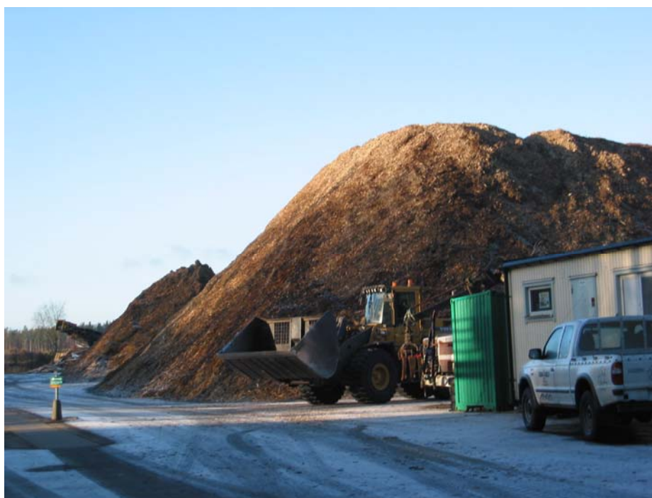
Befintlig flisanläggning, RagnsSells
