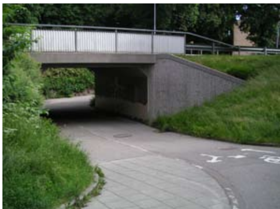
Tunnel under Järnvägsgatan förbinder gång- och cykelnätet
