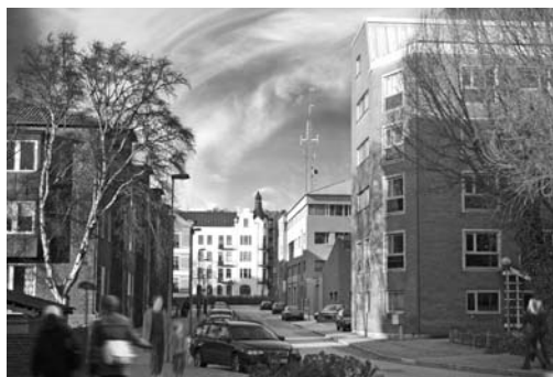
Vy från Seminariegatan mot polishuset, efter påbyggnad med ett våningsplan
