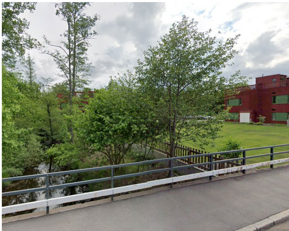
Figur 6 Fastigheten Thekannan 2 är utfylld till fastighetsgräns mot Bolanders bäck. En idag befintlig stödmur fungerar som skydd mot översvämning vid höga vattennivåer.
