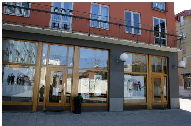
Stora glaspartier i sockelvåningen
