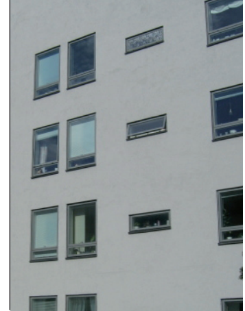
Fönster i fasadliv
