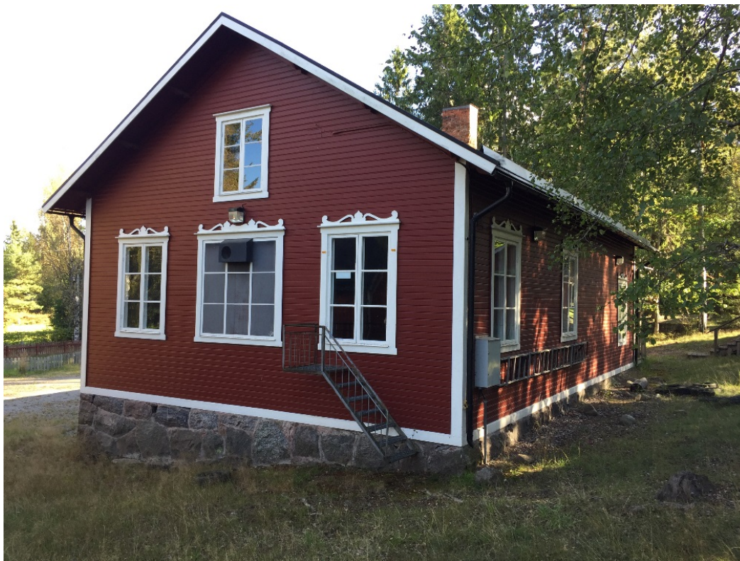
Gamla skolbyggnaden från nordväst.
