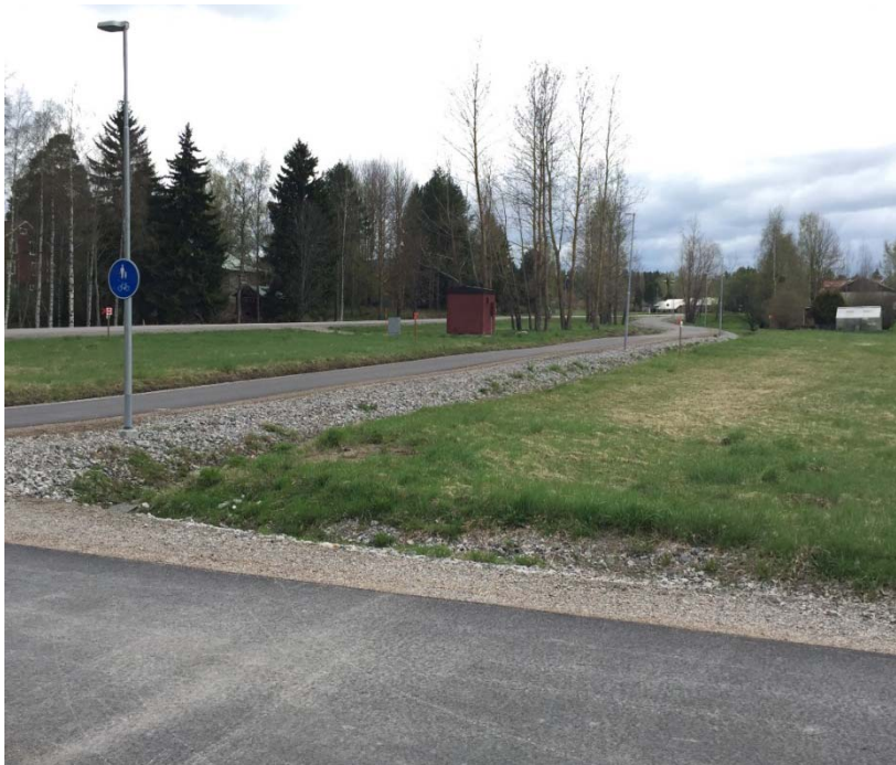
Gång- och cykelväg samt transformatorstation – från söder
