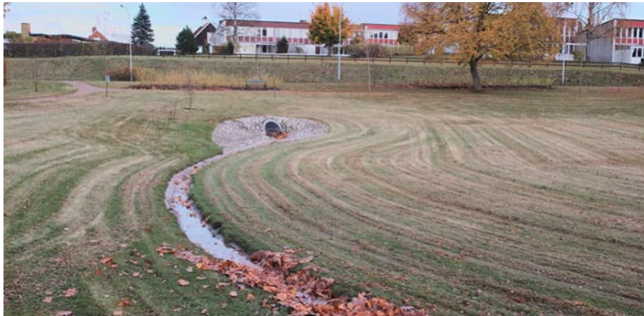
Bild 15. Exempel på torrdamm (Stockholm Vatten och avfall)
