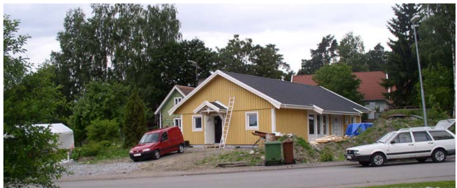
Bakom den nya huvudbyggnaden skymtar den äldre byggnaden som avses rivas.
