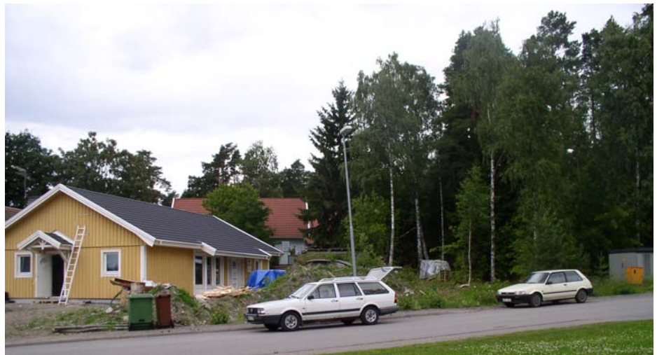
Den nya tomtgränsen kommer att gå 4.5 meter söder om transformatorstationen som skymtar till höger i bild. Tomtgränsen kommer att gå ungefär vid gränsen till trädvegetationen.
