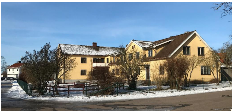
Bild 5. Fasader mot söder av huvudbyggnaden på fastigheten Harplinge 1:13 ( f.d. ålderdomshemmet och förskola)
