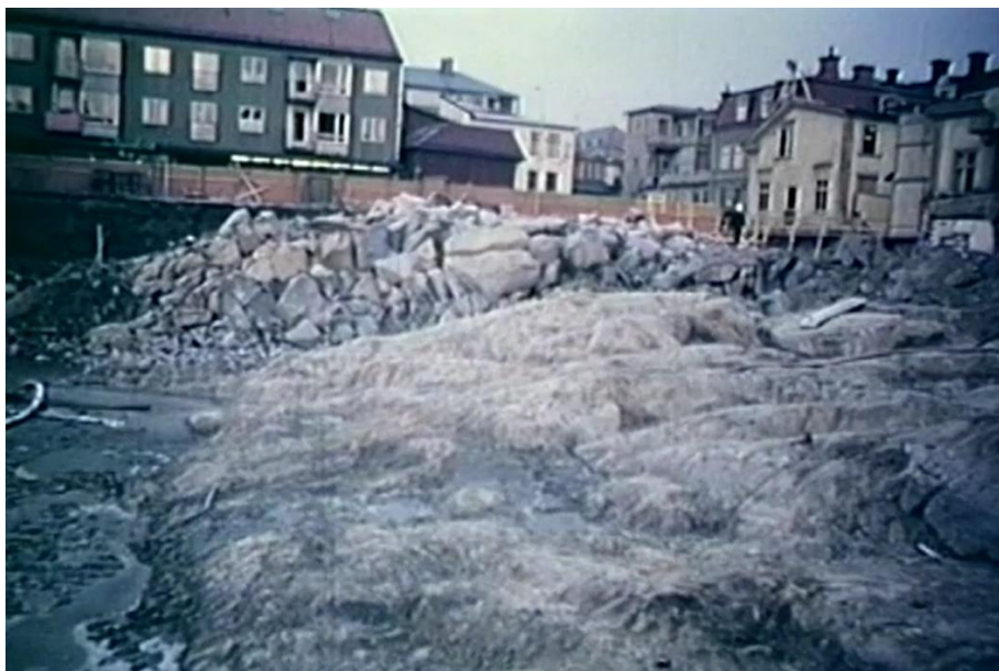
Bild som visar bergsprängning i kv London 1969 till 1970.
