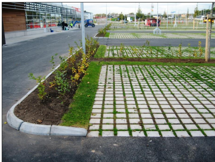
Parkeringsyta med genomsläpplig beläggning
