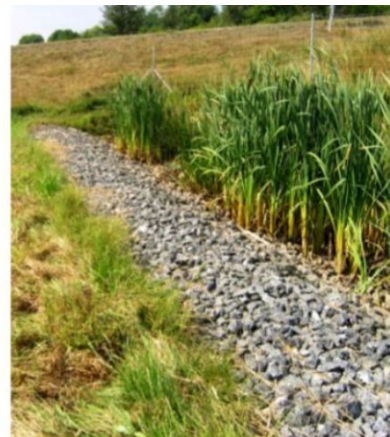
Exempel på anlagda dagvattenlösningar med sten för att minska erosion, sprida flöden och minska hastigheten på dagvatten.
