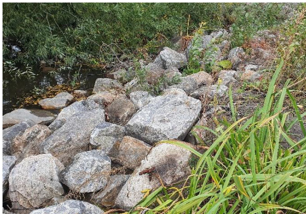
Exempel på anlagda dagvattenlösningar med sten för att minska erosion, sprida flöden och minska hastigheten på dagvatten.
