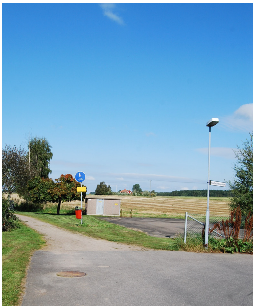
Gång- och cykelväg väster om planområdet samt transformatorstationen och angränsande åkermark.
