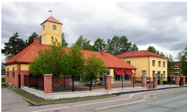
Vy från Västra Drottninggatan över tomten Västra Parken 17 (gamla brandstationen)
