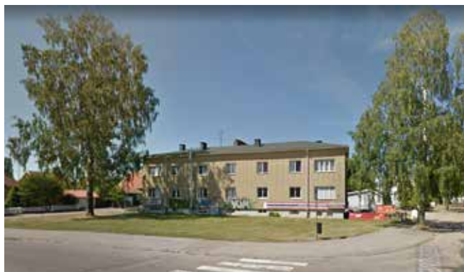
Befintlig byggnad inom fastigheten.
