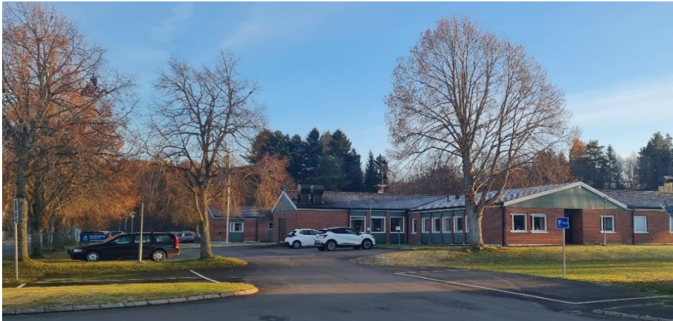
Hellidshemmets södra del med parkering.
