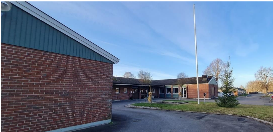
Huvudentré och fasader mot Von Essens väg.
