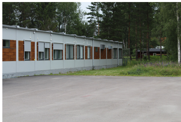
Ovan: Befintlig förskolebyggnad. Vy mot norr.
