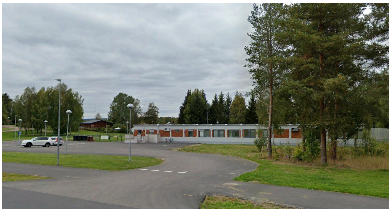
Ovan: Vy från Rosendalsvägen mot förskolans parkering och infart. Källa: Google Earth (2021).
