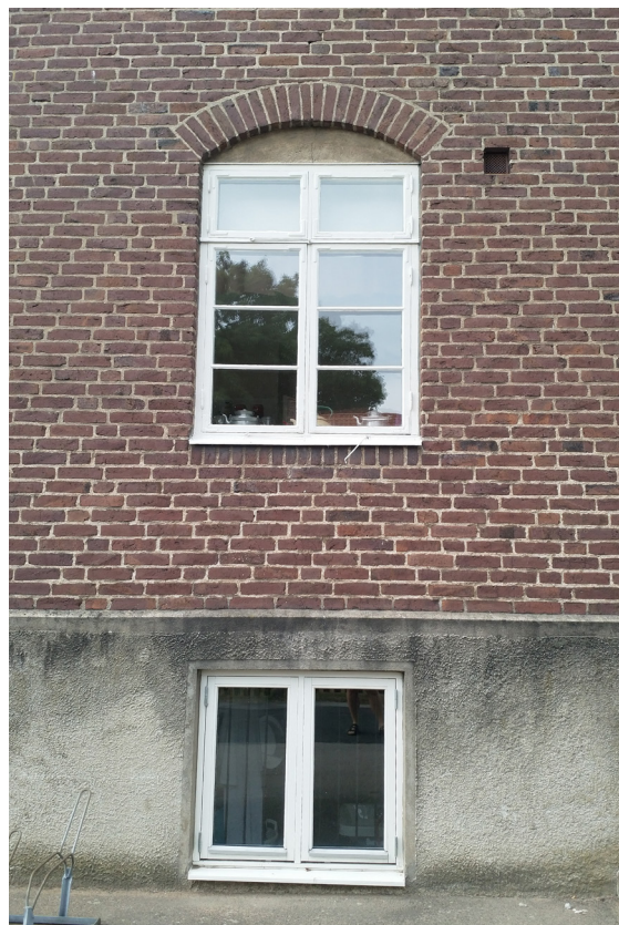
Originalfönster överst och utbytt nederst, södra gaveln
